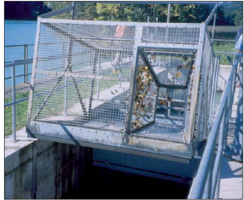
Abb. 20: Hochgezogene Kontrollreuse am oberen Ende des Vertical-Slot-Fischpasses (Bild: Ruhlé)
