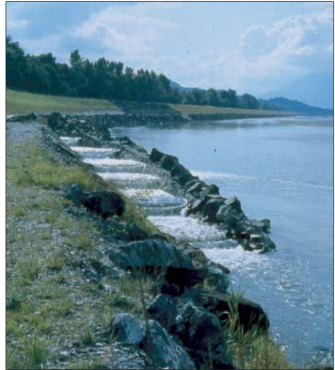
Abb. 17: Beckenpass als technische Lösung für das Aufstiegshindernis bei der Mündung des Liechtensteiner Binnenkanals (Bild: Ruhlé)
