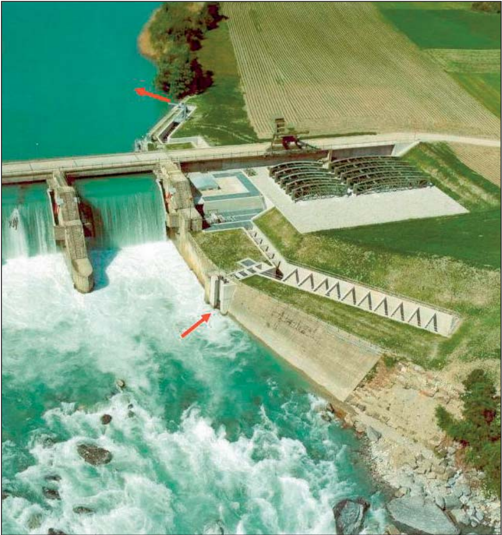
Abb. 19: Luftbild des linken Wehrteils des Kraftwerks Reichenau mit Vertical-Slot-Fischpass hinter der linksufrigen Böschungsmauer. Die untere und obere Öffnung des Passes sind mit roten Pfeilen markiert. (Bild: Tiefbauamt des Kantons Graubünden)
