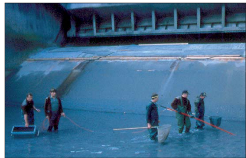
Abb. 24: Laichfischfang in den Wehrkolken des Kraftwerks Reichenau (Bild: Ruhlé)
